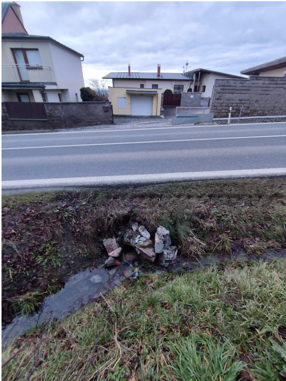
Příloha č. 2 - k bodu 10. Propustek pod silnicí I/14 – ve směru na Náchod (OV Vrchoviny 19.1.2023)
